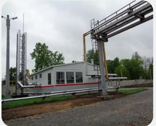
Блочно-модульные котельные теплопроизводительностью до 30 МВт на природном газе и других видах топлива с модулем резервного электроснабжения, очистными сооружениями и инженерными сетями
