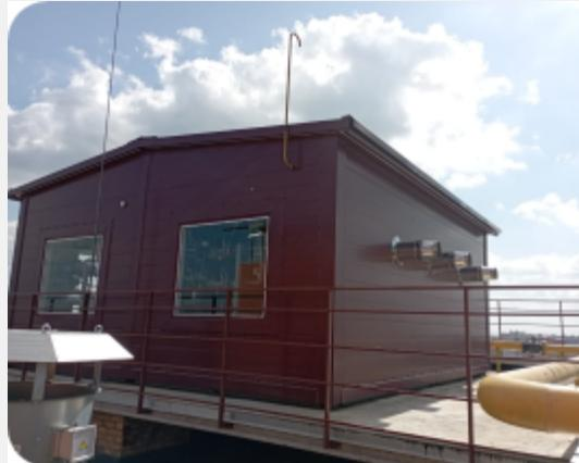
Блочно-модульные крышные котельные теплопроизводительностью до 5 МВт на природном газе
